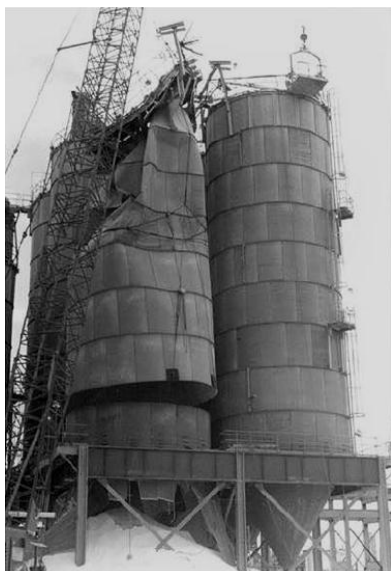
а) результат развития массового потока в бункере, запроектированном для воронкообразного потока
