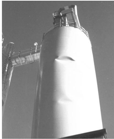
б) бункердің қабырғаларының жүк түсірудің жанында симметриялық емес ағынның әсер шақырылған орнықтылықтары жоғалту
